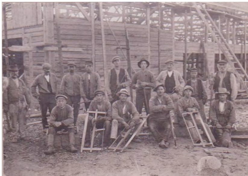
Ladugården vid Berg under byggnad.
